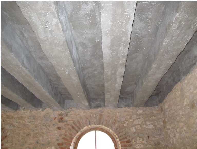
Konstruksioni meskatësh nga betonarmeja
